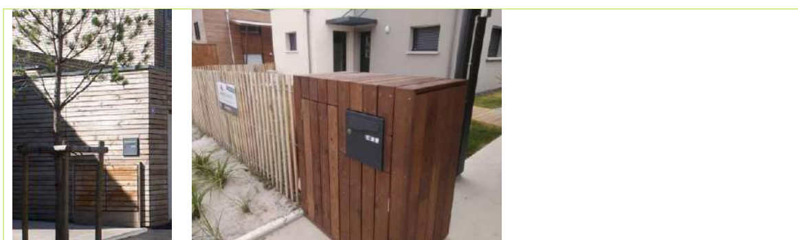
Image 52 - Intégration des éléments techniques dans la clôture
