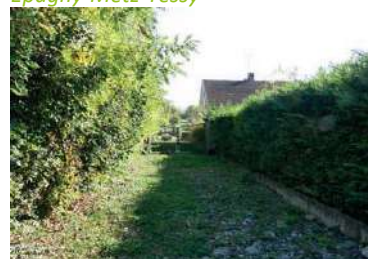
Accès enherbé sur mélange terre-pierre
