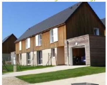
Stationnement accolé à la construction
