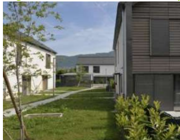
Coulée verte au sein du lotissement
