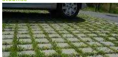
Pavés, joints enherbés
