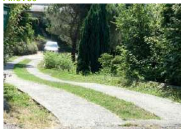
Bandes de roulement en béton, enherbement central
