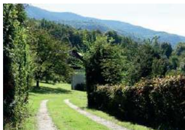
Accès enherbé, bandes de roulement en graviers
