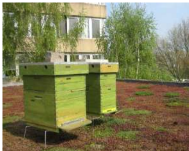
Ruche sur toiture végétalisée
